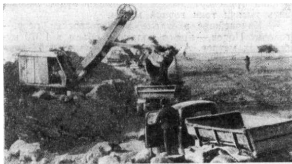
Работы по планировке строительной площадки почти полностью механизированы.
