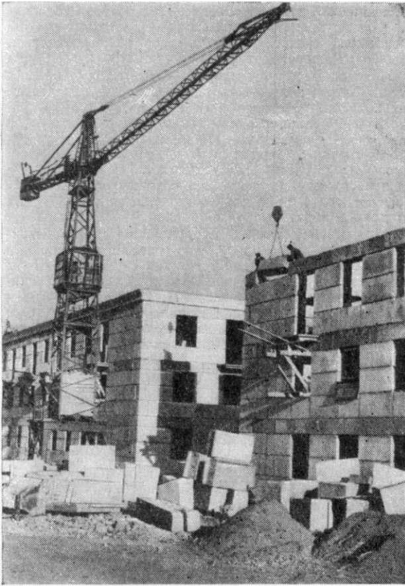
Крупноблочный метод строительства позволяет возводить жилые дома в короткие сроки.
