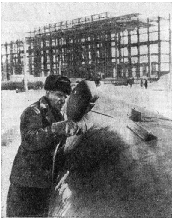
Знатный электросварщик Петр Иванович Роман уже 15 лет работает на стройках Казахстана — на Балхаше, Джезказгане и Петропавловске. Сейчас он занят сваркой труб новой ТЭЦ.
